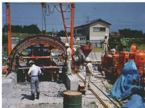
トンネル（新トンネル工法）へ
