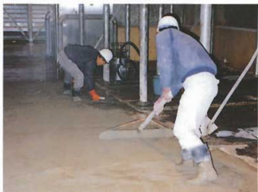
床改修工事へ
