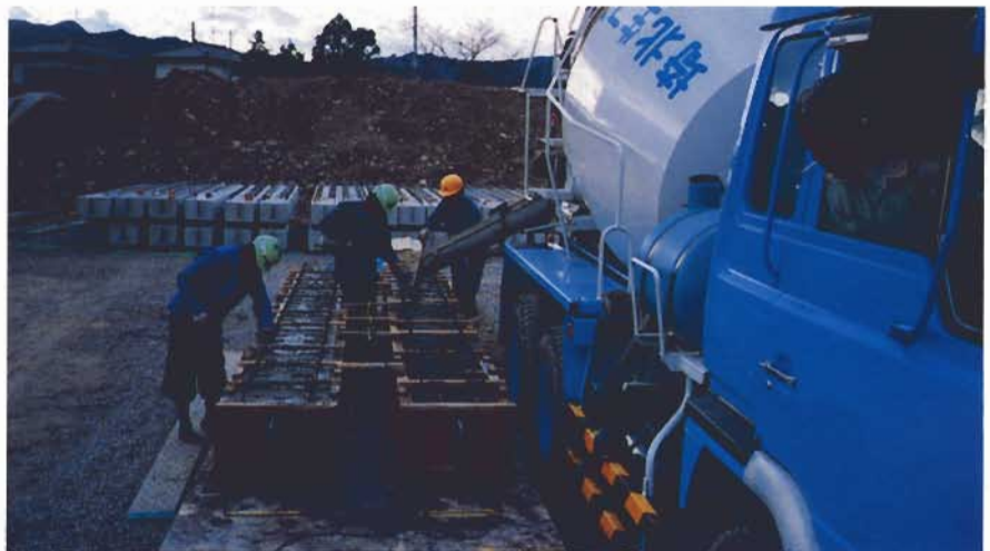
現場打ちプレキャスト部材の製造に
