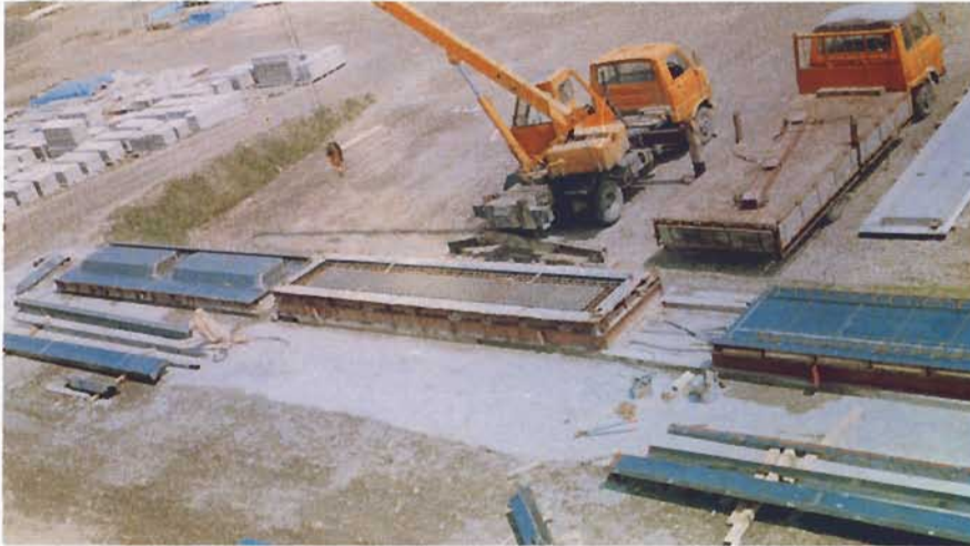
現場打ちプレキャスト部材の製造に
